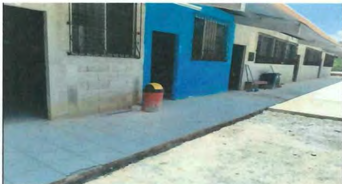
Foto 9: Pintura exterior y interior de 3 aulas, direccion, sanitarios y corredor.
