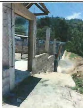
Foto 8: colocacion de puerta en la entrada del instituto de 1 metros de anchos y 2 metros de alturas
