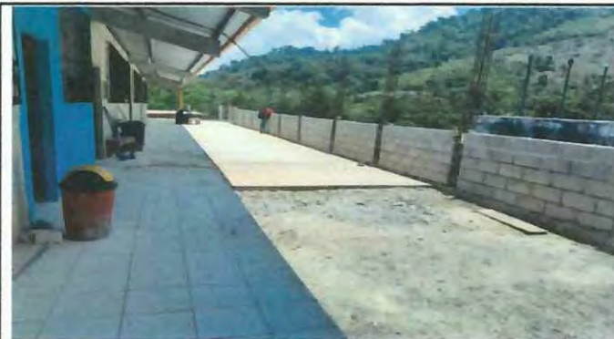
Foto 2: Instalacion de estructura portante de metal, en corredor 120.75 M2.
