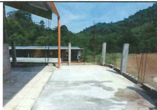
Foto 6: colocacion de block para muro perimetral de 25 Metros de largo X 1.08 de altura.
