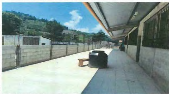
Foto1: Corredor, instalacion cubierta lamina troquelada de aluzinc calibre 26, 120..75M2
