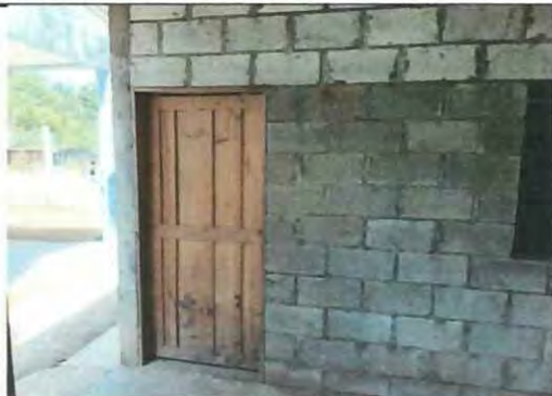
Foto7: Sustrucion de puerta de cocina a metal de 1 metros de anchos y 2 metros de alturas
