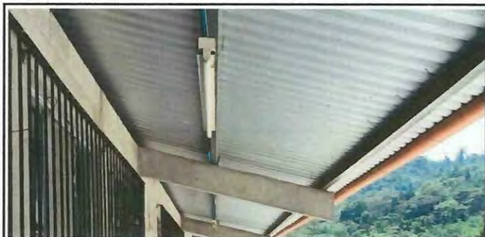
Foto 11: cambia y sustitucion de la base de bombilla a plafonera de todos el aulas.
