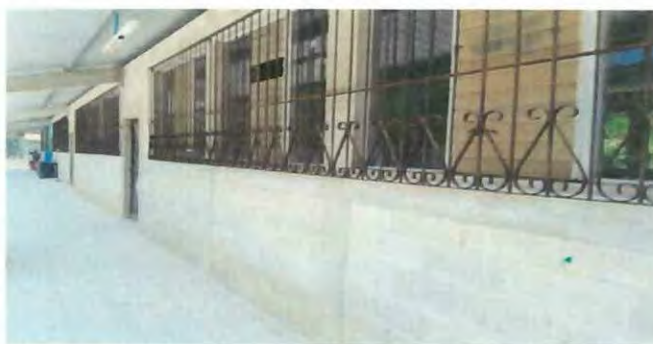
Foto 10: Pintura exterior y interior de 3 aulas, direccion, sanitarios y corredor. 300 M2
