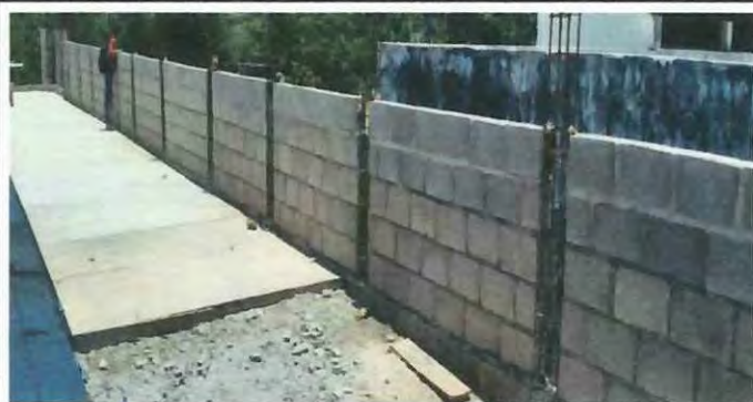
Foto 3: fundicion de 16 columnas de 0.25 m x 0.30 m x 2.50 m alto
