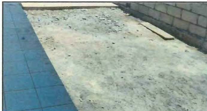
Foto 4: REPARACION PANCHA DE CONCRETO DE PATIO POR 30 M2
